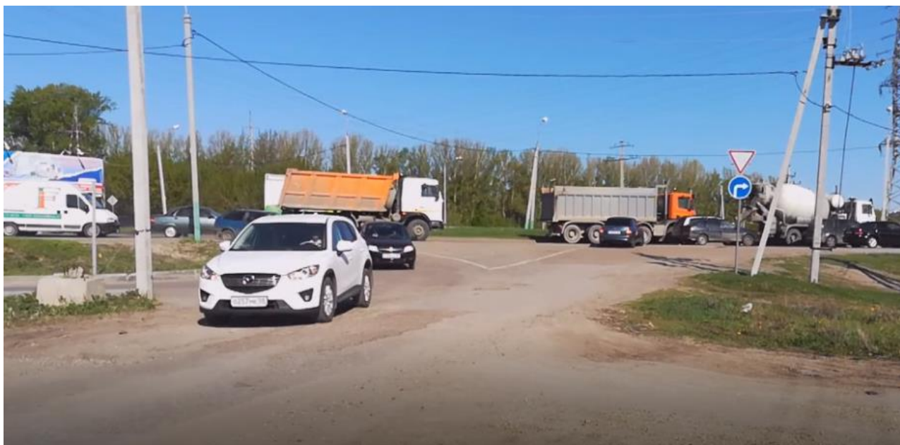
Рисунок 37 – Фотография пересечения ул. Ижевского – ул. 40-лет Октября
